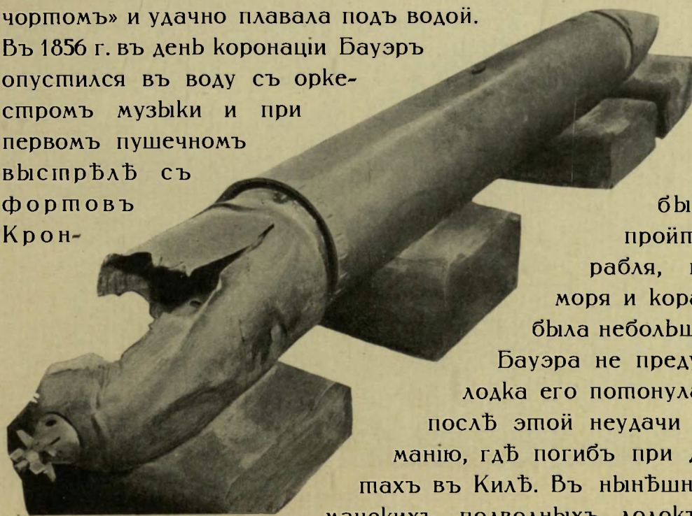
Турецкая мина Уайтхеда, попавшая въ винты лодки «Кубанецъ».
