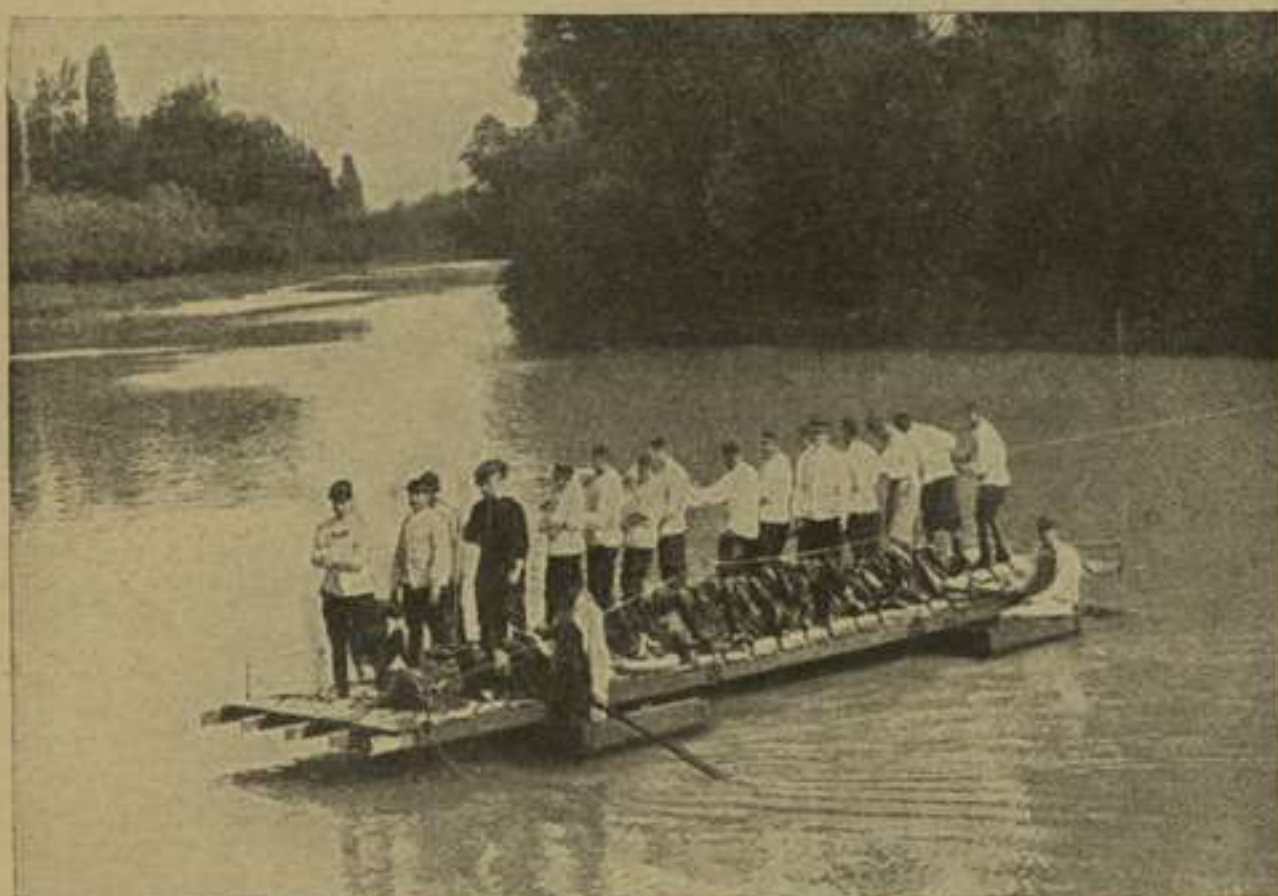
Переправа части понтонного моста сапёрами.
