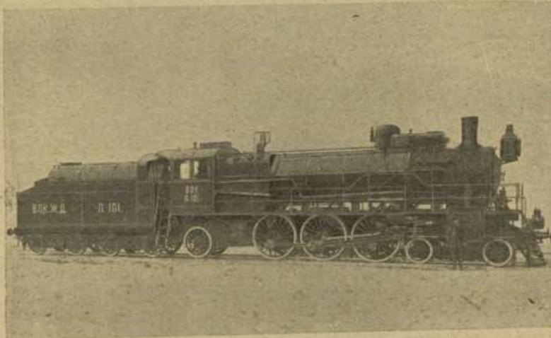
Паровозъ-гигантъ Владиванкаской желѣзн. дор. усовершенствованнаго типа «ПАСИФИКЪ». 30 апрѣля было произведено испытаніе на переходѣ «Петроградъ—Онуловка», средняя скорость 85—90 верстъ въ часъ.
