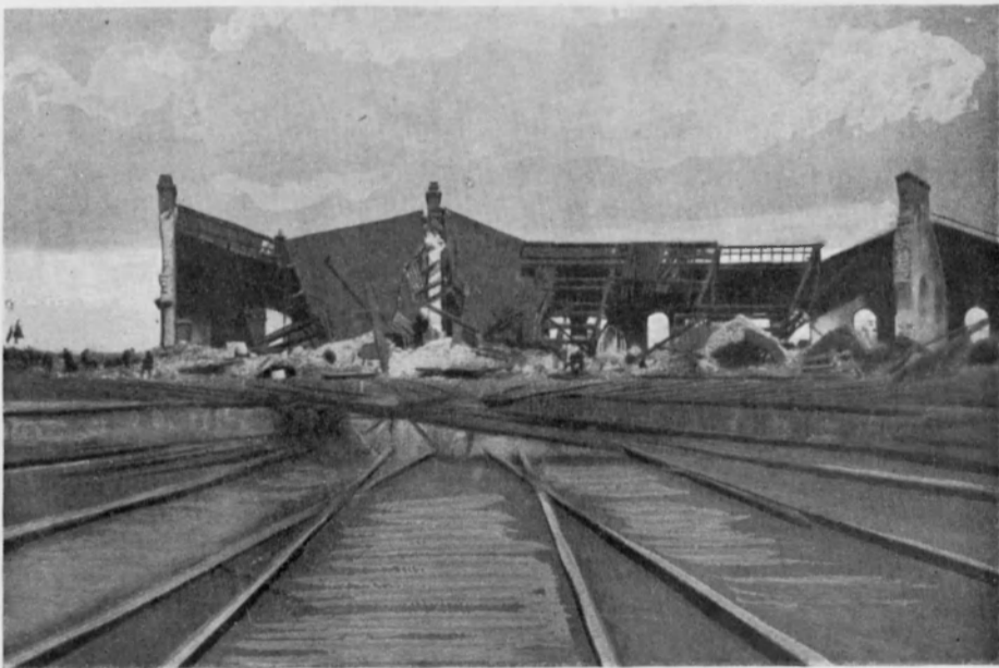
Депо на ст. Лодзь, разрушенное нѣмцами.
